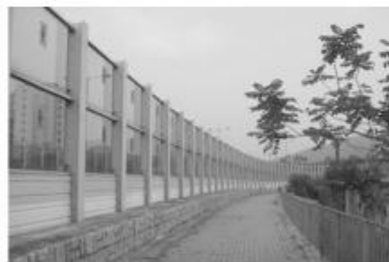
丙: 公路两旁安 装隔音板
